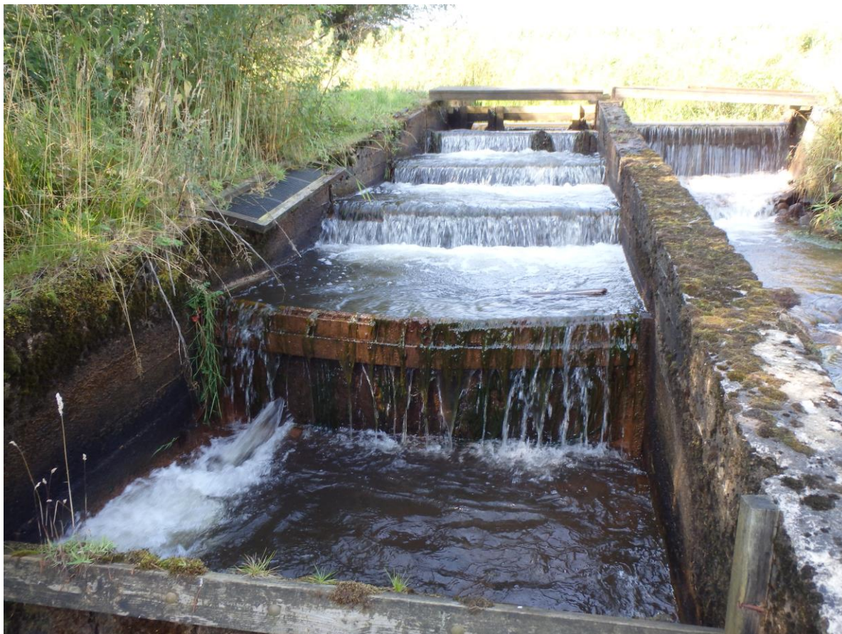
Fiskekammertrappen ved Høghøj Dambrug
